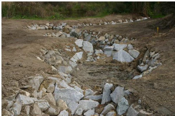
Abb. 1 Naturnaher Fischaufstieg im Bau
