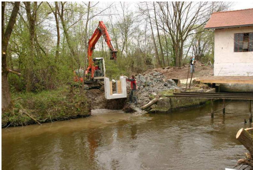
Abb. 7 Aufstellen der Elemente im Unterwasserbereich
