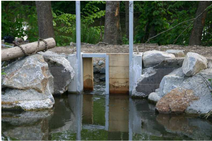
Abb. 8 Ausleitungsbauwerk vom Oberwasser her gesehen
