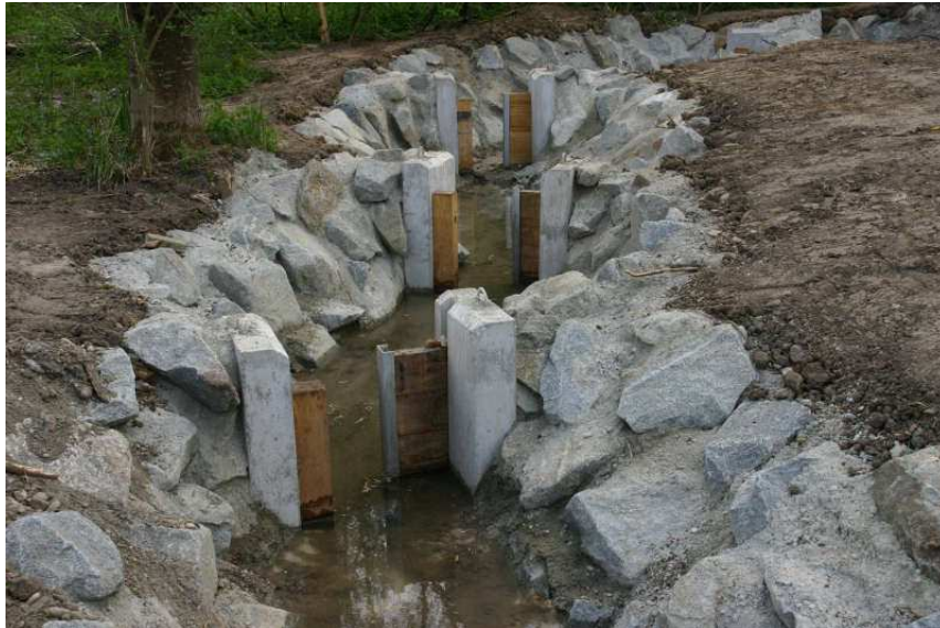
Abb. 6 Die Beckenwände sind mit Granitsteinen gesichert
