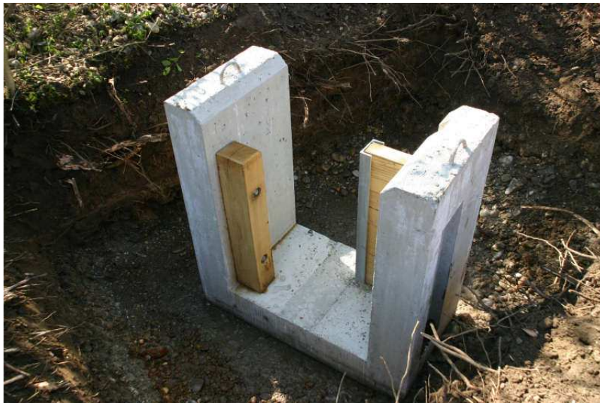
Abb. 5 Schlitzelement, an Sollposition und Sollhöhe aufgestellt
