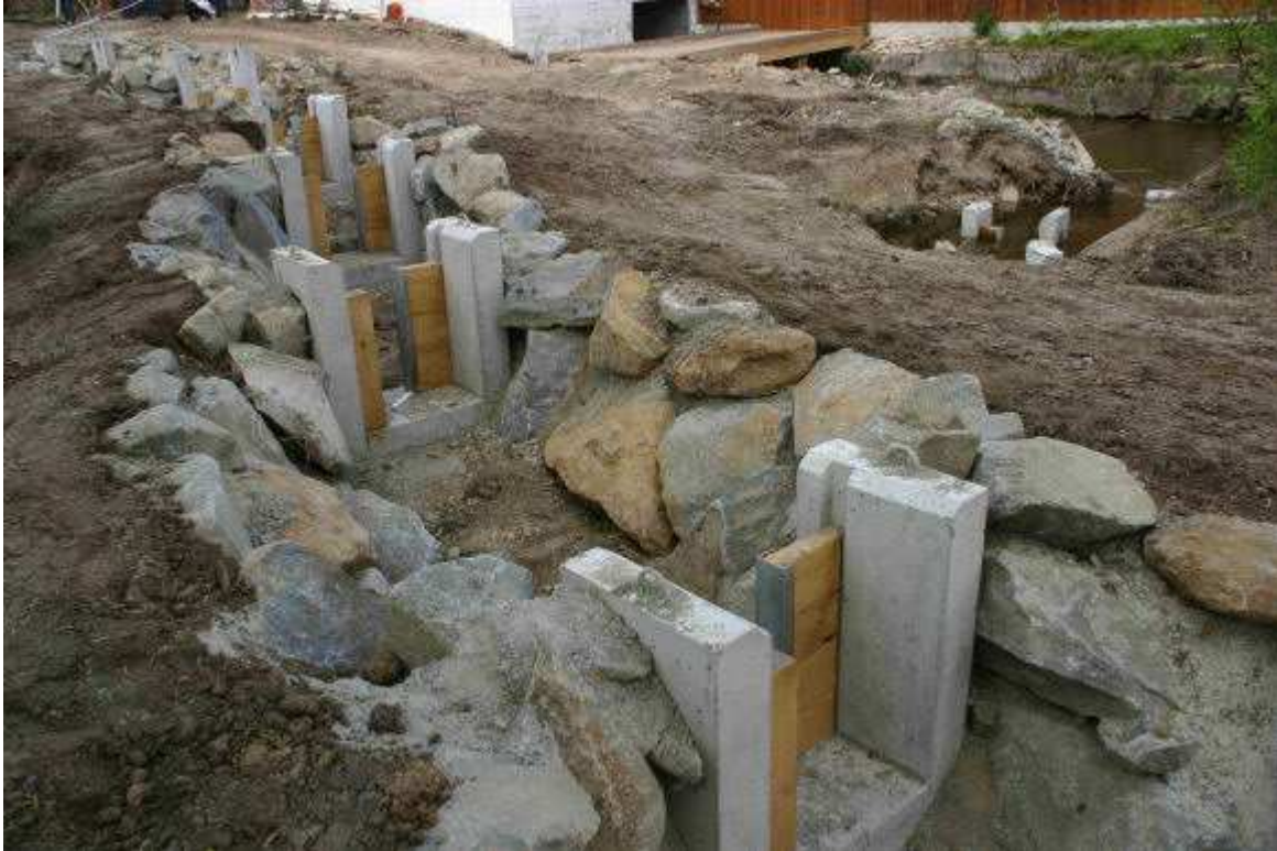
Abb.3 Fischaufstieg mit Uferbefestigung, noch ohne Sohlsubstrat:
