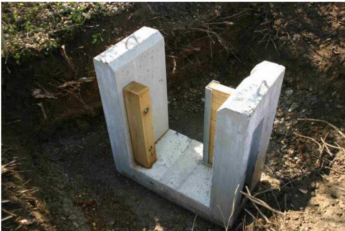
Abb.2: Ein Schlitzelement ist aufgestellt
