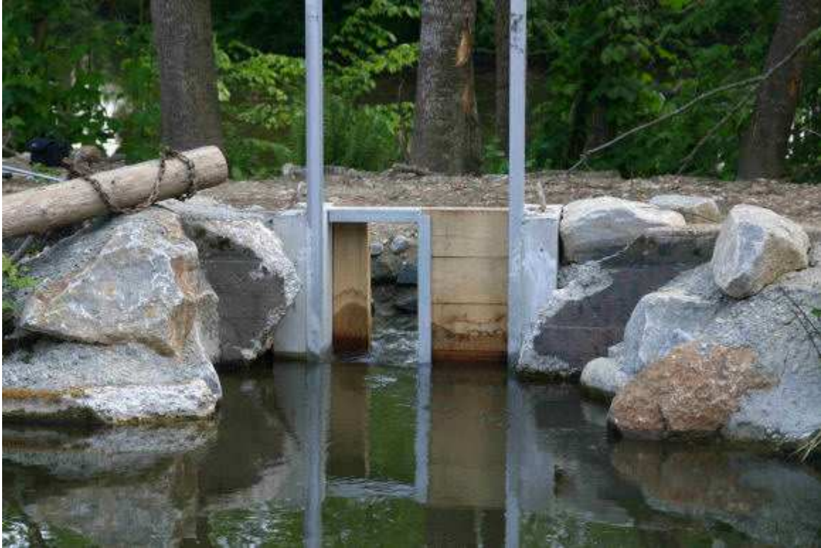
Abb.4: Ausleitungsbauwerk mit hohem Schlitz zur Begrenzung der Wassermenge
