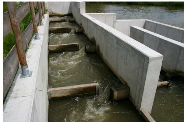
Abb. 2 Beispiel für einen technischen Fischaufstieg
