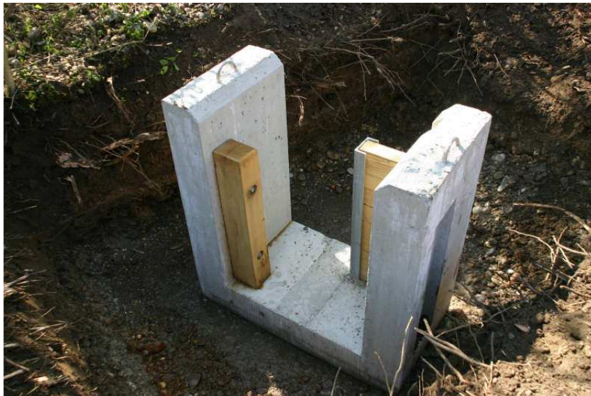
Abb. 5 Schlitzelement, an Sollposition und Sollhöhe aufgestellt
